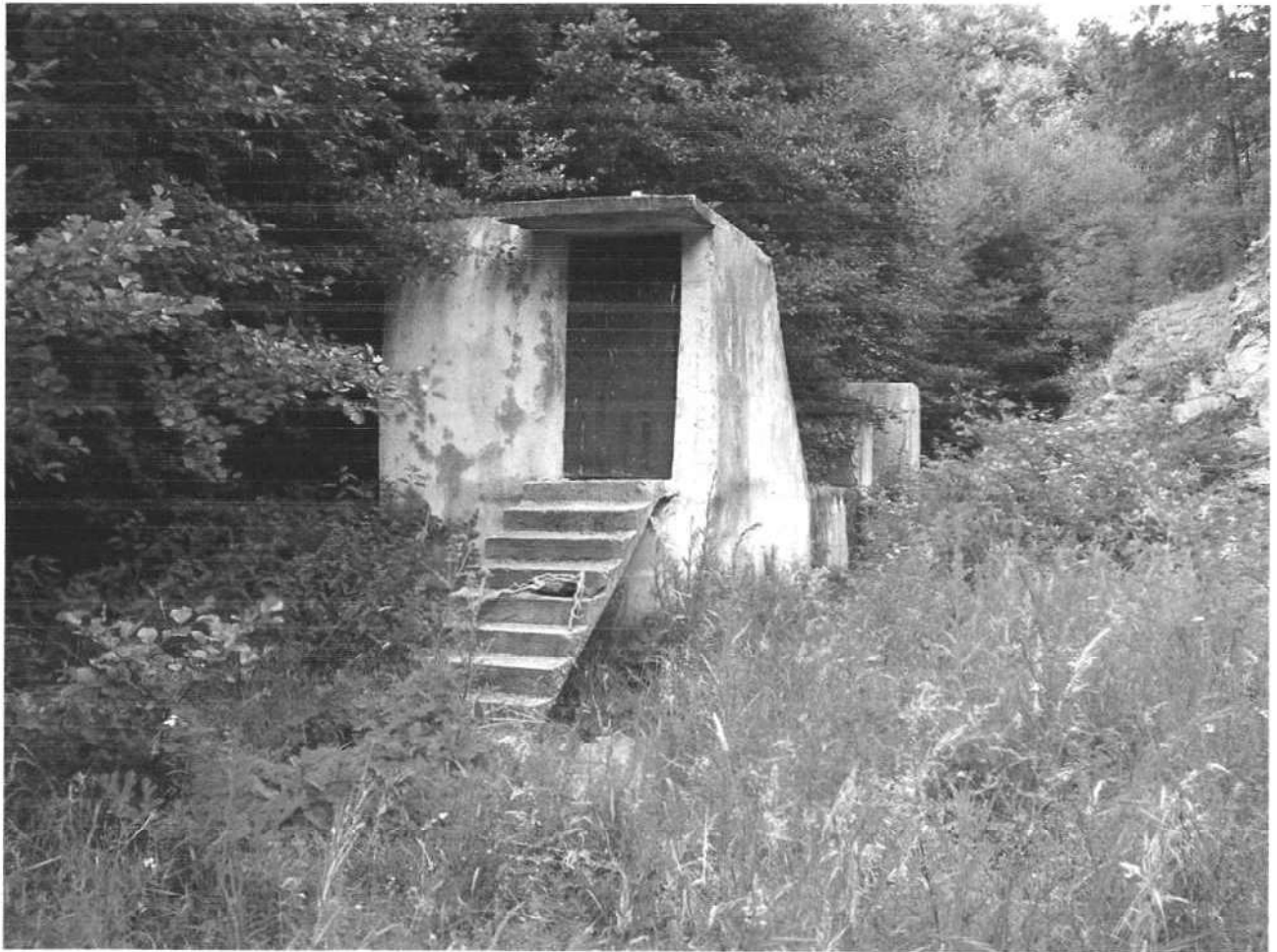
Снимка 2. Облекчителна шахта
